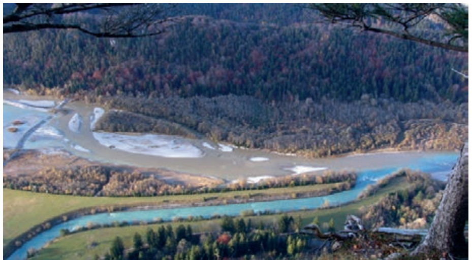
Der Füssener Lech ist der letzte Rest der ehemaligen bayerischen Wildflusslandschaft von Landesgrenze bis zur Donau. Durch gezielte wasserbauliche Eingriffe (untere Bildmitte) soll die einzigartige Lechaue wieder belebt werden (Aufnahme Februar 2014). Foto: Peter Nasemann
