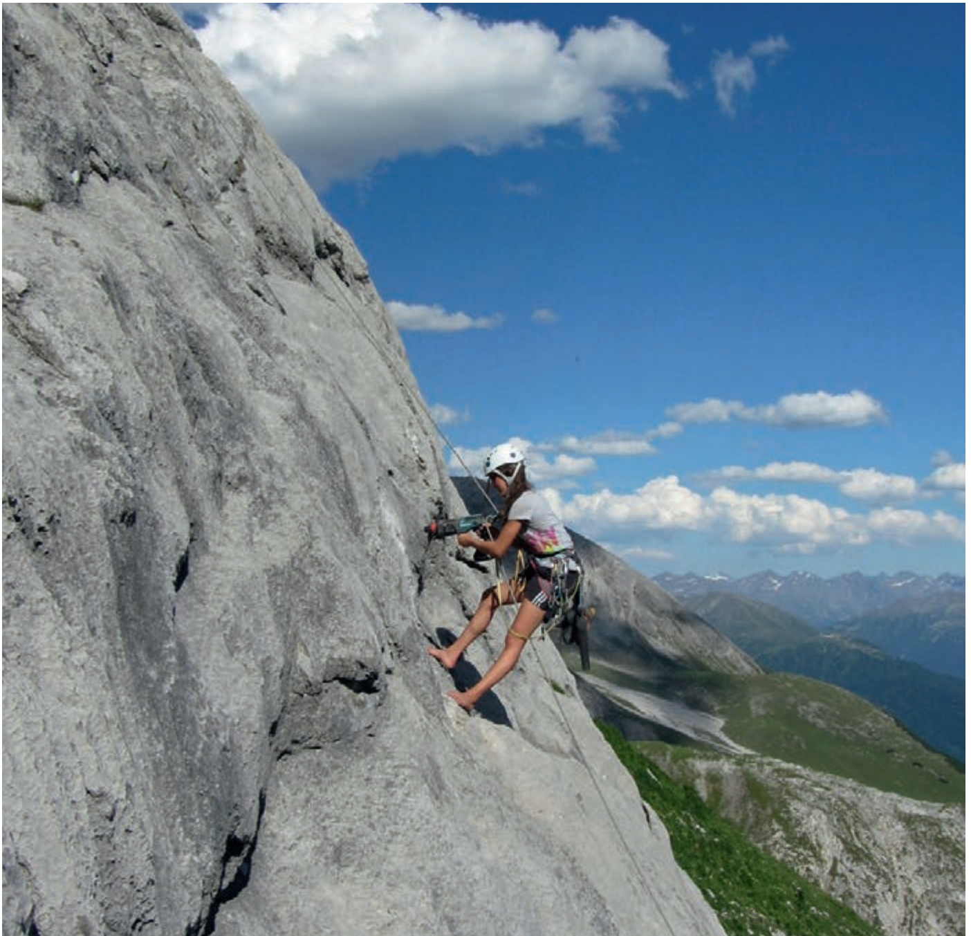
Alina (Stützpunkt Augsburg) beim Einbohren im Hittawandla. Foto: Kathrin (Stützpunkt Augsburg)
